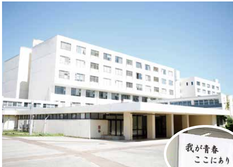
旧A1号館正面玄関
